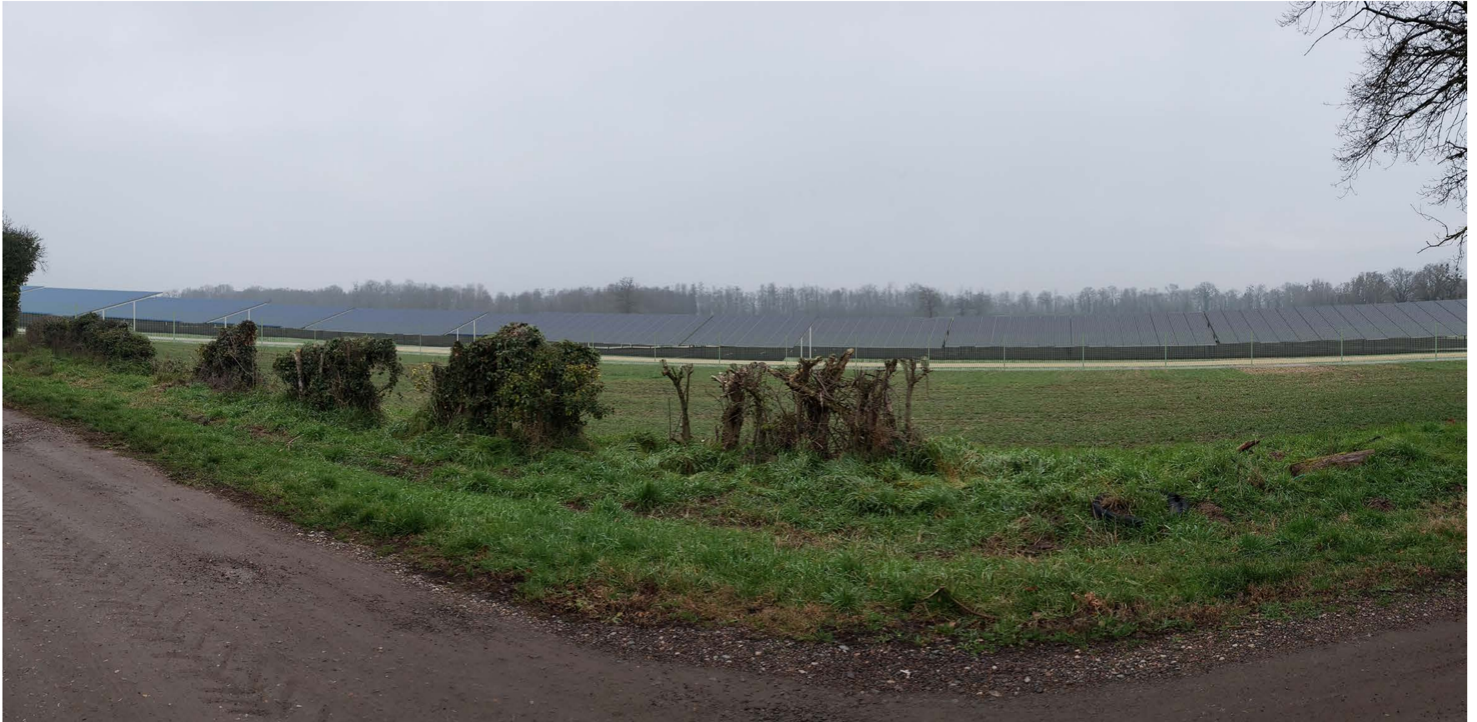
PV2 - Vue depuis le Sud-Est du projet
